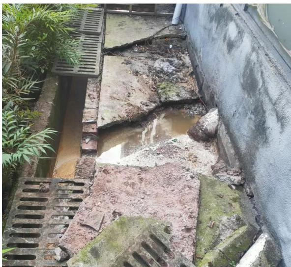
部门领导得知情况后,火速赶到现场,根据现场情况迅速组织相关人员采取应急处理,临时堵住散水沟排水口,用水泵将污水抽到隔油池,不让污水继续流入河道。从而进一步勘查现场,制定下一步抢修方案。在不影响食堂正常供餐的前提下,白天开挖散水沟外到隔油池段污水管,晚上10点食堂下班以后开挖散水
