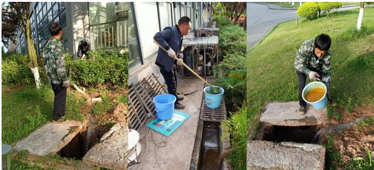
整个施工过程中我部工作人员全程现场值守，因地下一根给水管和两根天然气管交错，加上施工部位狭窄，操作困难，严重影响抢修施工进度。我部工作人员根据开挖后现场实际情况，在保证给水管和天然气管不受影响情况下，果断调整排污管道安装位置，最终在凌晨 2 点完成新管道的安装，确保了食堂的正常用水和早餐的正常供应。
